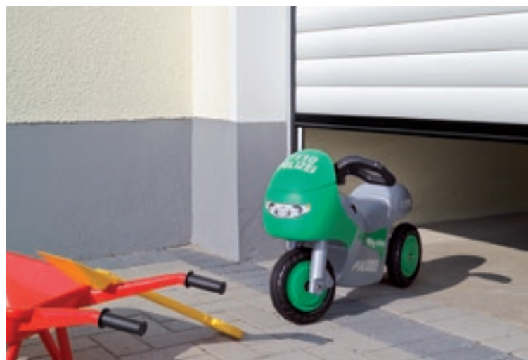
Die Abschaltautomatik stoppt das Tor bei Hindernissen
